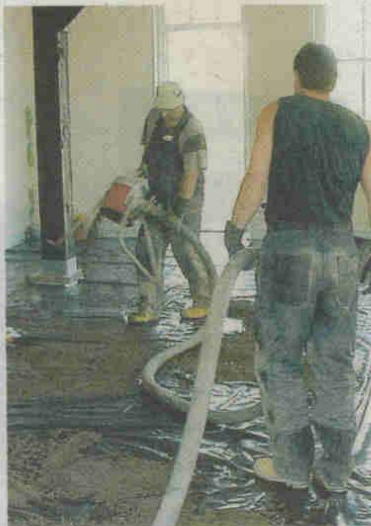
Mittels Pumpe wird der Fließestrich auf den Boden aufgebracht. KK
